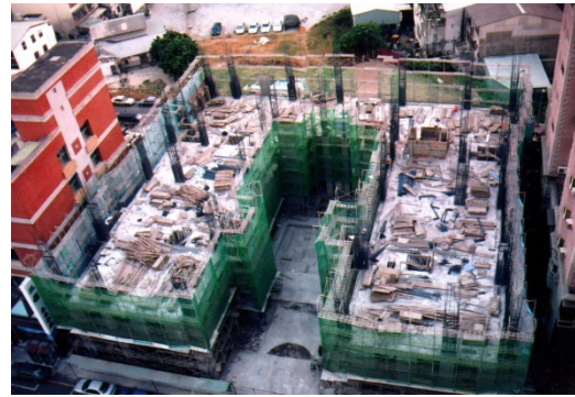
圖 5 鉅虹○○新建工地灌漿後情形
