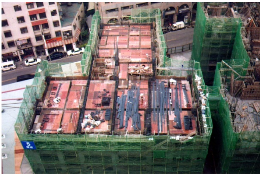
圖 2 順天○○A 棟新建工地灌漿前情形
