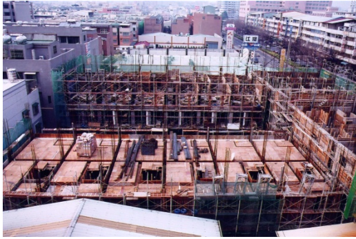
圖 1 久鼎○○A 棟新建工地灌漿前情形
