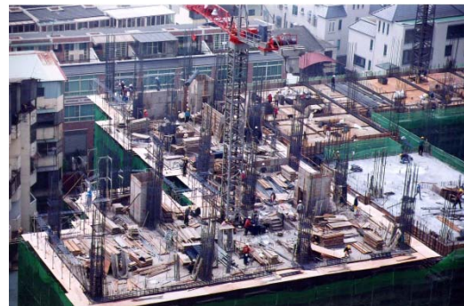
圖 6 鄉林○○D區新建工地灌漿後情形
